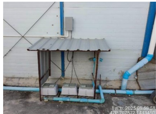
รูปที่ 2-31 : ระบบบำบัดน้ำเสียแบบเติมอากาศ บริเวณอาคารสำนักงานและบ้านพักคนงาน
