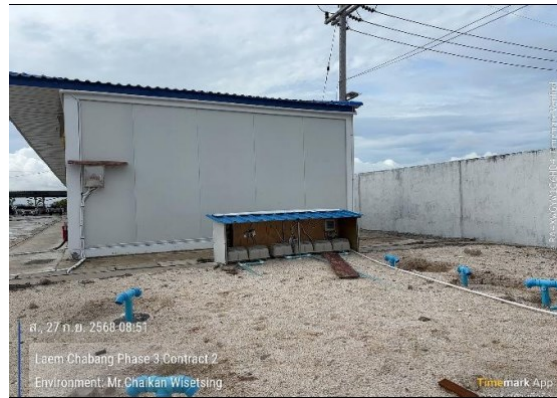
รูปที่ 2-30 : ระบบบำบัดน้ำเสียสำเร็จรูปบริเวณพื้นที่ก่อสร้าง
