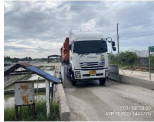
รูปที่ 2-17 : ล้างล้อก่อนออกจากพื้นที่โครงการ
