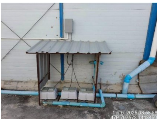
รูปที่ 2-31 : ระบบบำบัดน้ำเสียแบบเติมอากาศ บริเวณอาคารสำนักงานและบ้านพักคนงาน
