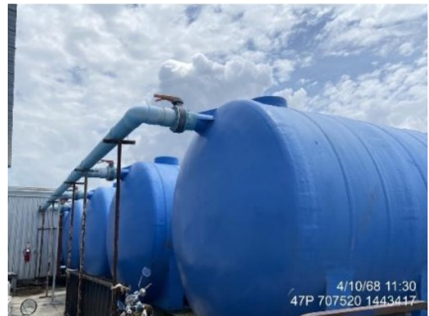
รูปที่ 2-67 : ถังเก็บน้ำใช้ (ปริมาตรรวม 400 ลูกบาศก์เมตร)
