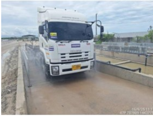
รูปที่ 2-17 : ล้างล้อก่อนออกจากพื้นที่โครงการ
