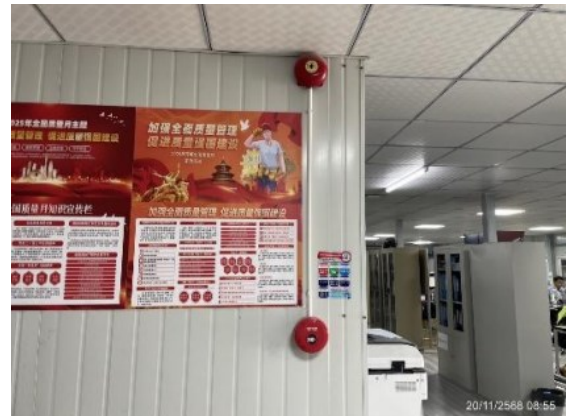
รูปที่ 2-100 สัญญาณเตือนเพลิงไหม้
