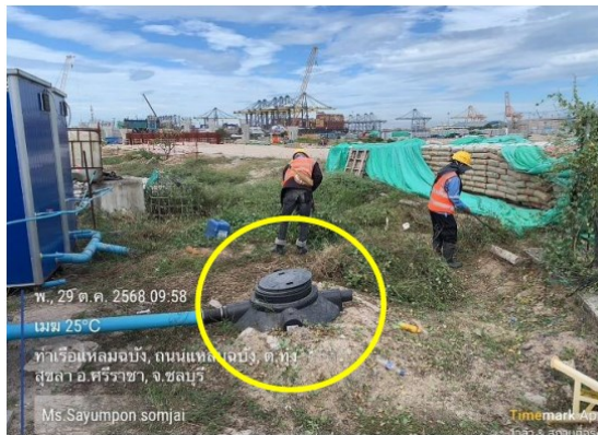
รูปที่ 2-30 : ระบบบำบัดน้ำเสียสำเร็จรูปบริเวณพื้นที่ก่อสร้าง
