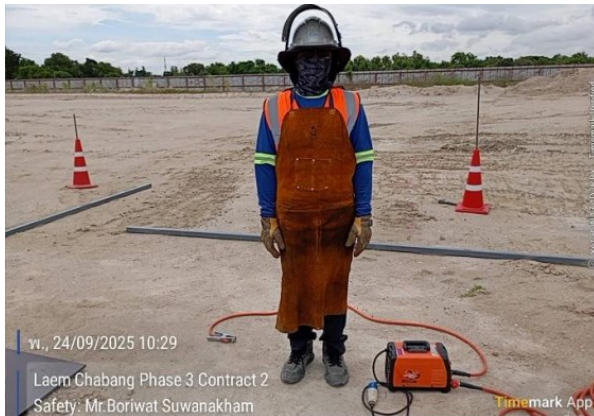
รูปที่ 2-99 การจัดเตรียมและสวมใส่อุปกรณ์ คุ้มครองความปลอดภัยส่วนบุคคล (ต่อ)
