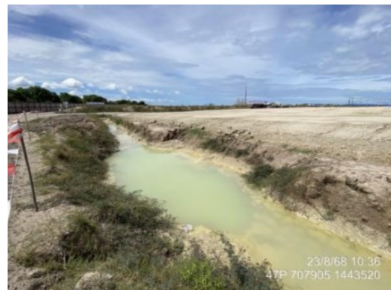
รูปที่ 2-36 : บ่อตกตะกอนบริเวณพื้นที่ก่อสร้าง
