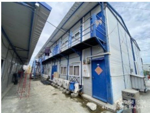
รูปที่ 2-16 : วัสดุสำเร็จรูปในการก่อสร้าง บ้านพักคนงานก่อสร้าง
