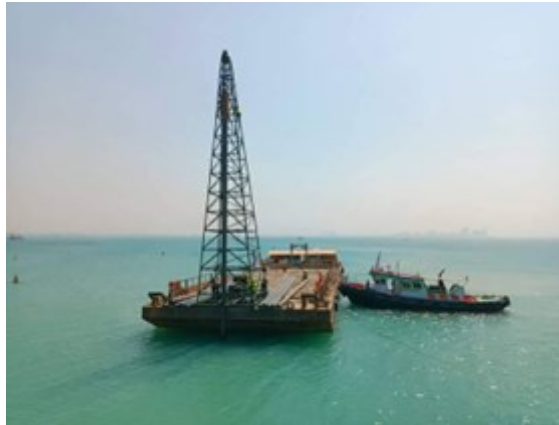
รูปที่ 2-1 : เครนตอกเสาเข็มบนเรือท้องแบน ก่อสร้างจุดขนถ่ายวัสดุพร้อมหลักผูกเรือ (ชั่วคราว)
