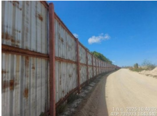
รูปที่ 2-6 : ติดตั้งรั้วปิดมิดชิด ด้านที่ติดกับ ชุมชน
