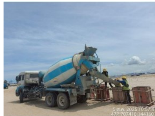
รูปที่ 2-15 : การใช้คอนกรีตผสมเสร็จ
